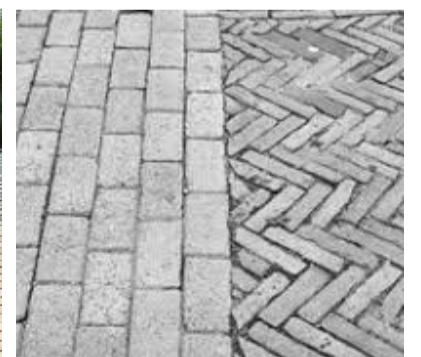
Verschillen in bestrating (in kleur dan wel materiaal) om de weg optisch smaller te laten lijken.
