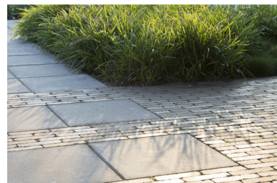
Verschillen in bestrating (in kleur dan wel materiaal) om de weg optisch smaller te laten lijken.
